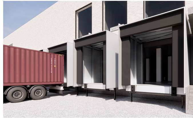
LASTEHUSE 2 av lastehus utstyrt med løftebord system
