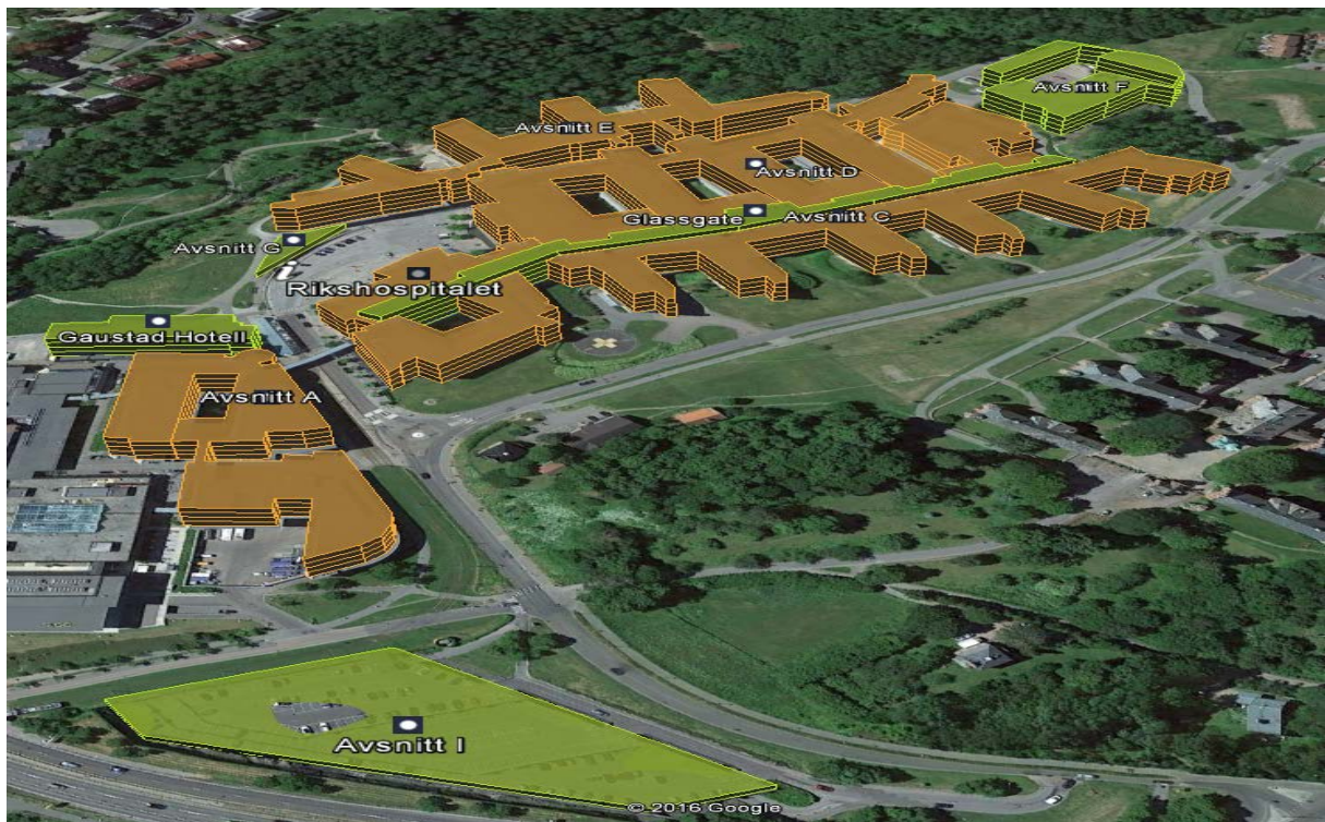
Oversikt teknisk tilstand Rikshospitalet, 2017
