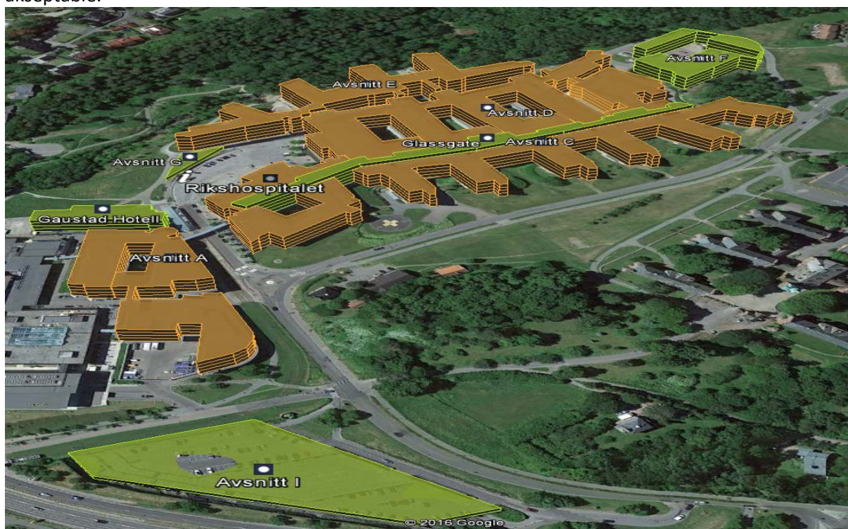
Oversikt teknisk tilstand Rikshospitalet, 2017
