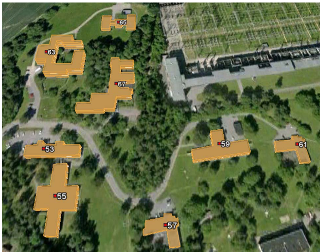
Figur 35. Teknisk tilstand Sognsvannsveien.
