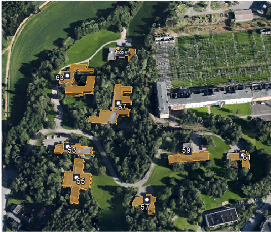
Fig. 9: Teknisk tilstand Sognsvannveien
