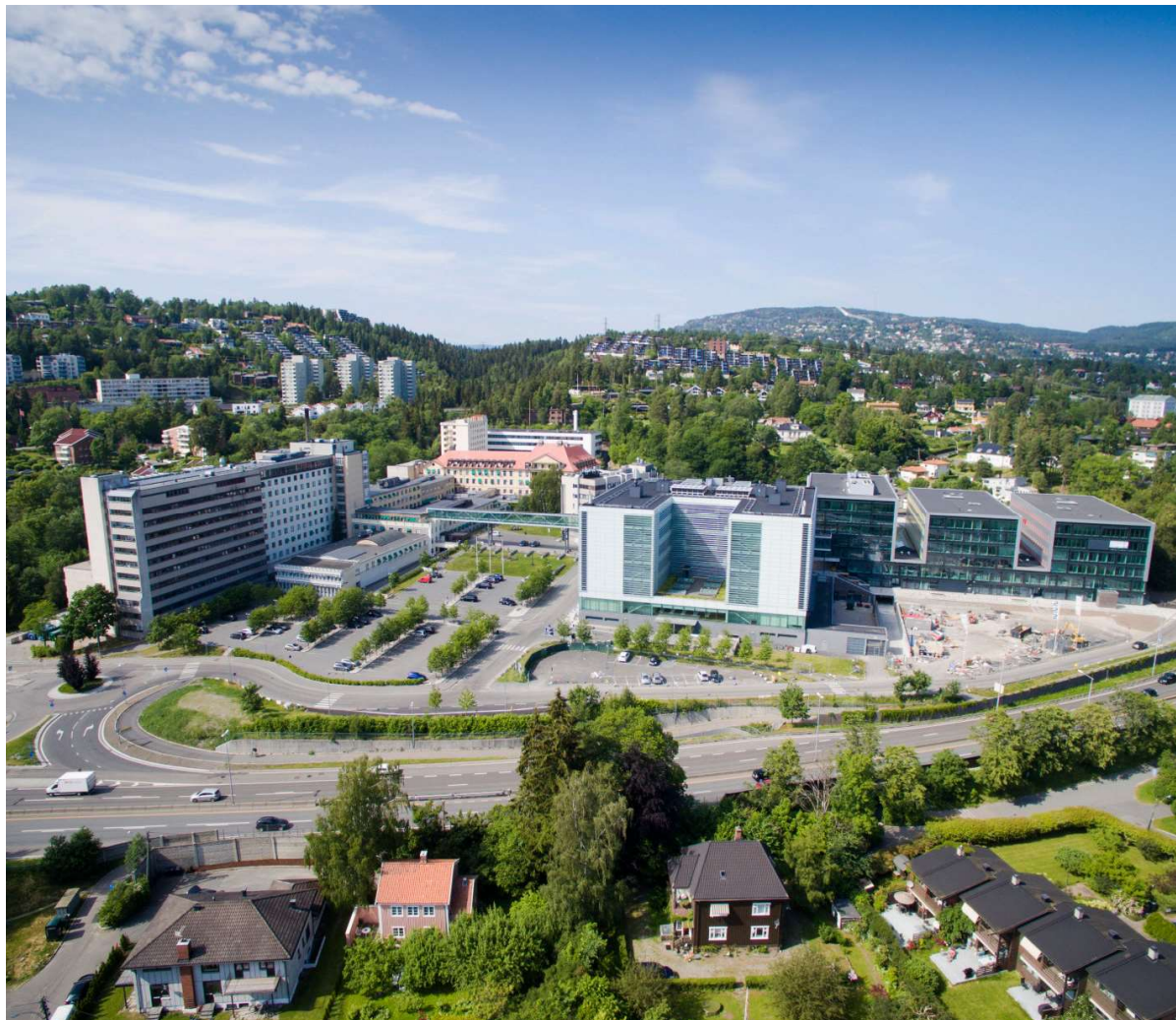
Figur 20: Luftfoto fra sør, før rivearbeidene startet
