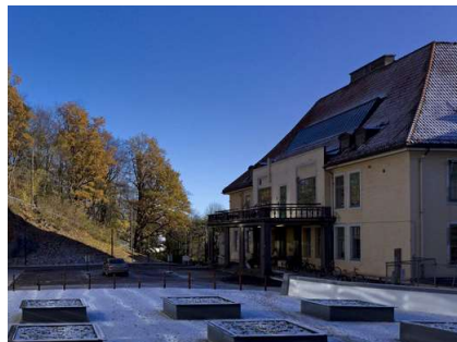
Figur 17: Bygg F sett fra hotellplassen
