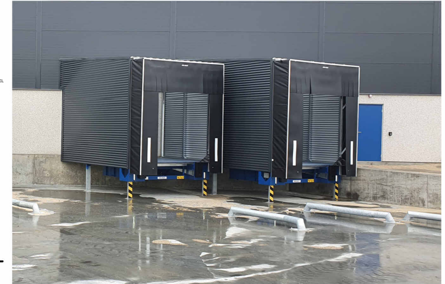
Porthus 6,7 og 8 stålunderstøttede/rampe. 45° Tette flaps utvendig og isolert leddport med varmluftsgardin innvendig.
