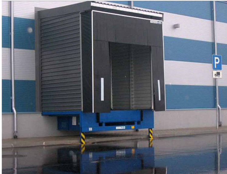
Porthus 2,3 og 4 stålunderstøttede/rampe. 90° Tette flaps utvendig og isolert leddport med varmluftsgardin innvendig.
