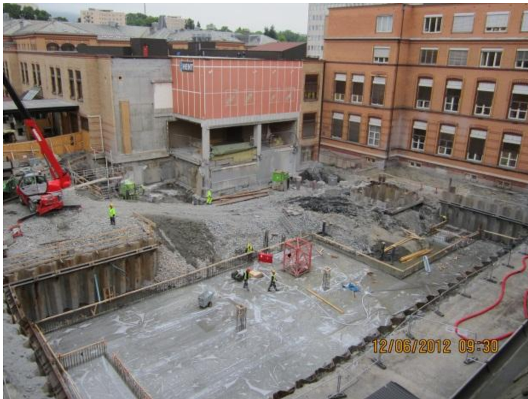
En meget trang og krevende byggeplass med spunting – «silent piling» - tett inntil eksisterende bygninger med klinisk virksomhet.
