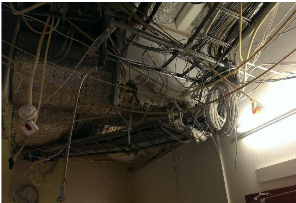
Omfattende arbeid med tekniske anlegg i eksisterende arealer som skulle bygges om.
