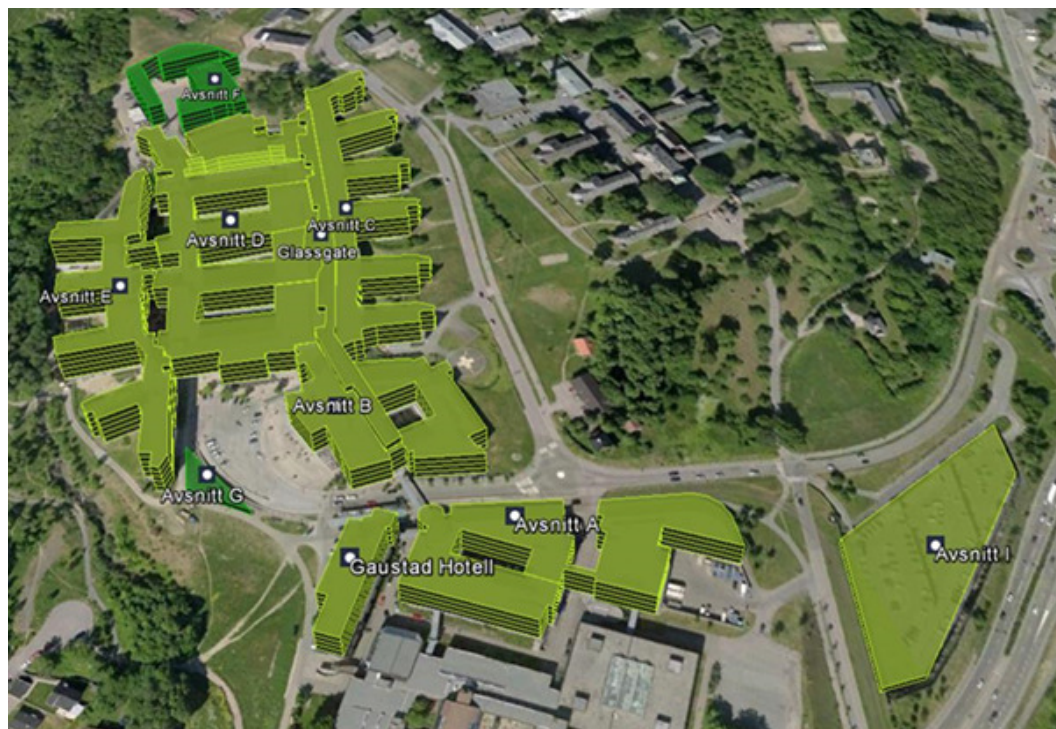
Oversikt teknisk tilstand Rikshospitalet, 2014
